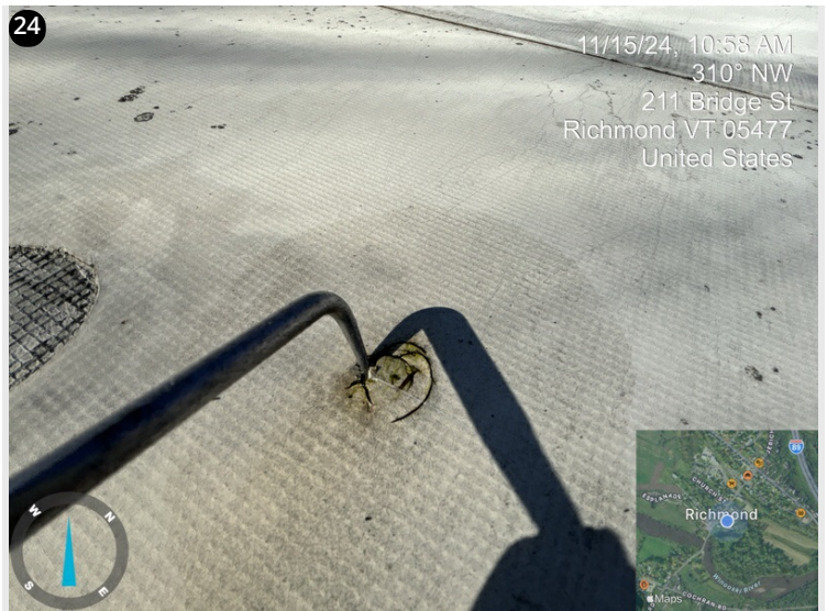
Hole in membrane.
